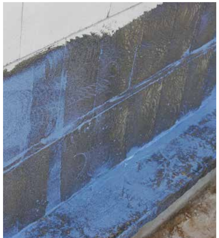
Farbumschlag der Kratzspachtelung mit MB 1K rapid
